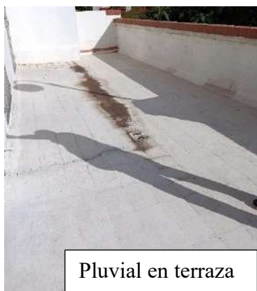
Filtración entre capas de losa terraza
