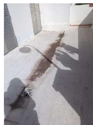
Filtración entre capas de losa terraza
