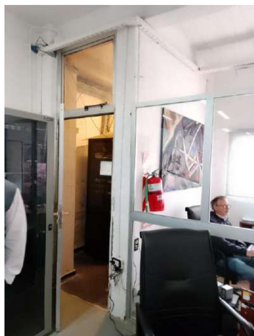
Demolición mampostería interna sala de RAC
